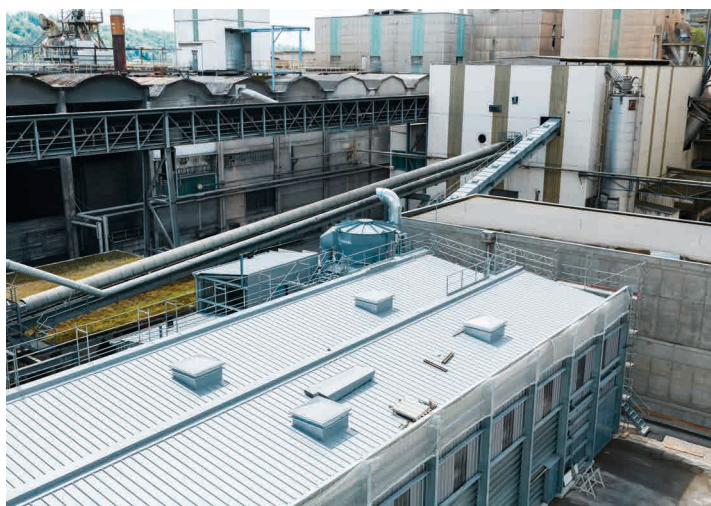
Projet Flame : Nouvelle installation pour combustibles alternatifs (©Daniel Hager)
