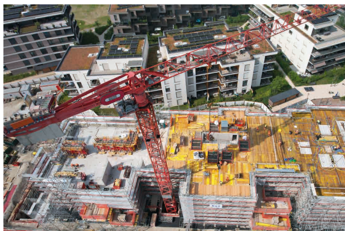
Construction du quartier Arbora à Crissier
