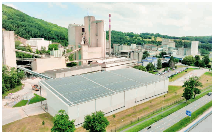
Installation photovoltaïque de la cimenterie
