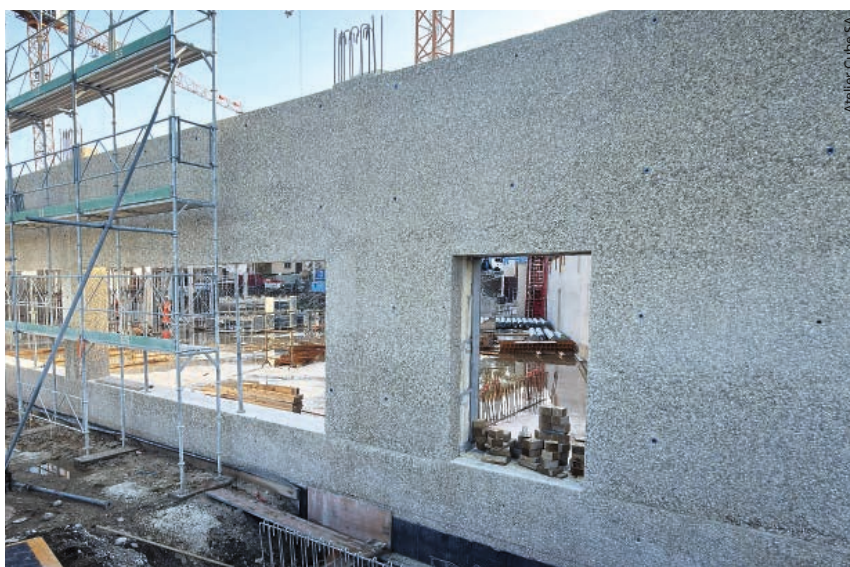
La façade du bâtiment. Le béton Ammocret est désactivé.
