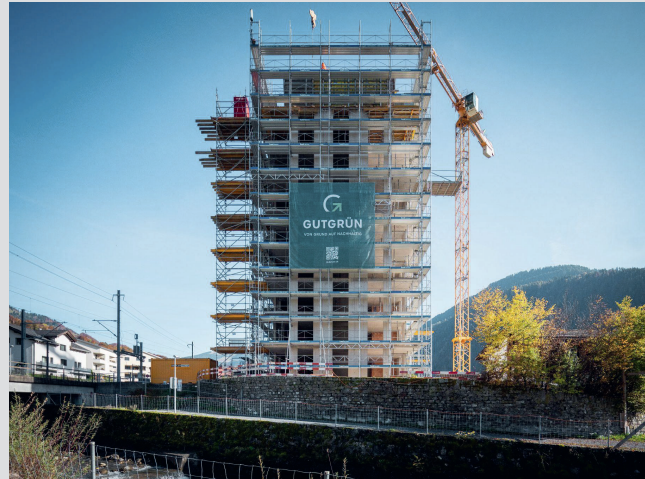
Rohbau mit Recyclingbeton auf Basis von Holcim Susteno 4
