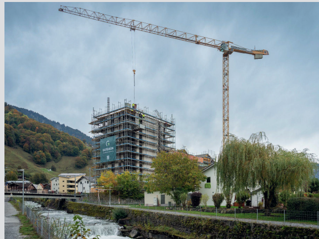
Nachhaltiges Bauen in der Region sichtbar umgesetzt
