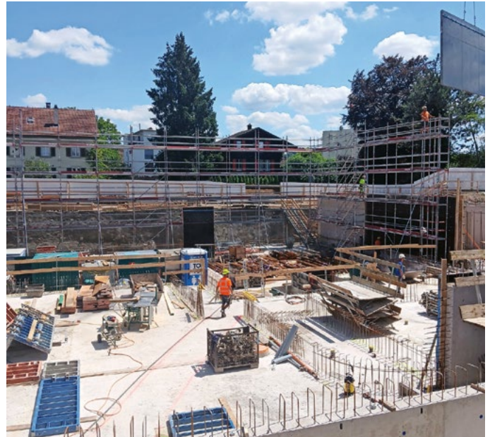
Baustelle Schulanlage Guss in Bülach. (Foto: Anliker AG)
