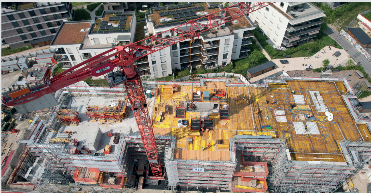
Chantier Arbora à Crissier vue aérienne
