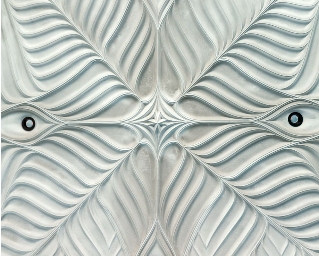
Système de plancher Rippmann sur le pavillon HiLo du Laboratoire fédéral d'essai des matériaux et de recherche (EMPA).
