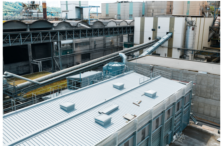
Foto: Zwei neue Lagerhallen und eine Anpassung des Ofens sorgen im Zementwerk in Eclépens für die Massenverwertung von nicht rezyklierbaren Kunststoffresten als Ersatzbrennstoffe für fossile Brennstoffe.
