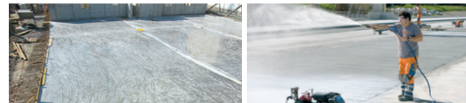
Abdecken einer Betondecke mit Kunststoffolie
