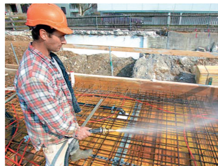
Vornässen von Bewehrung und Schalung
