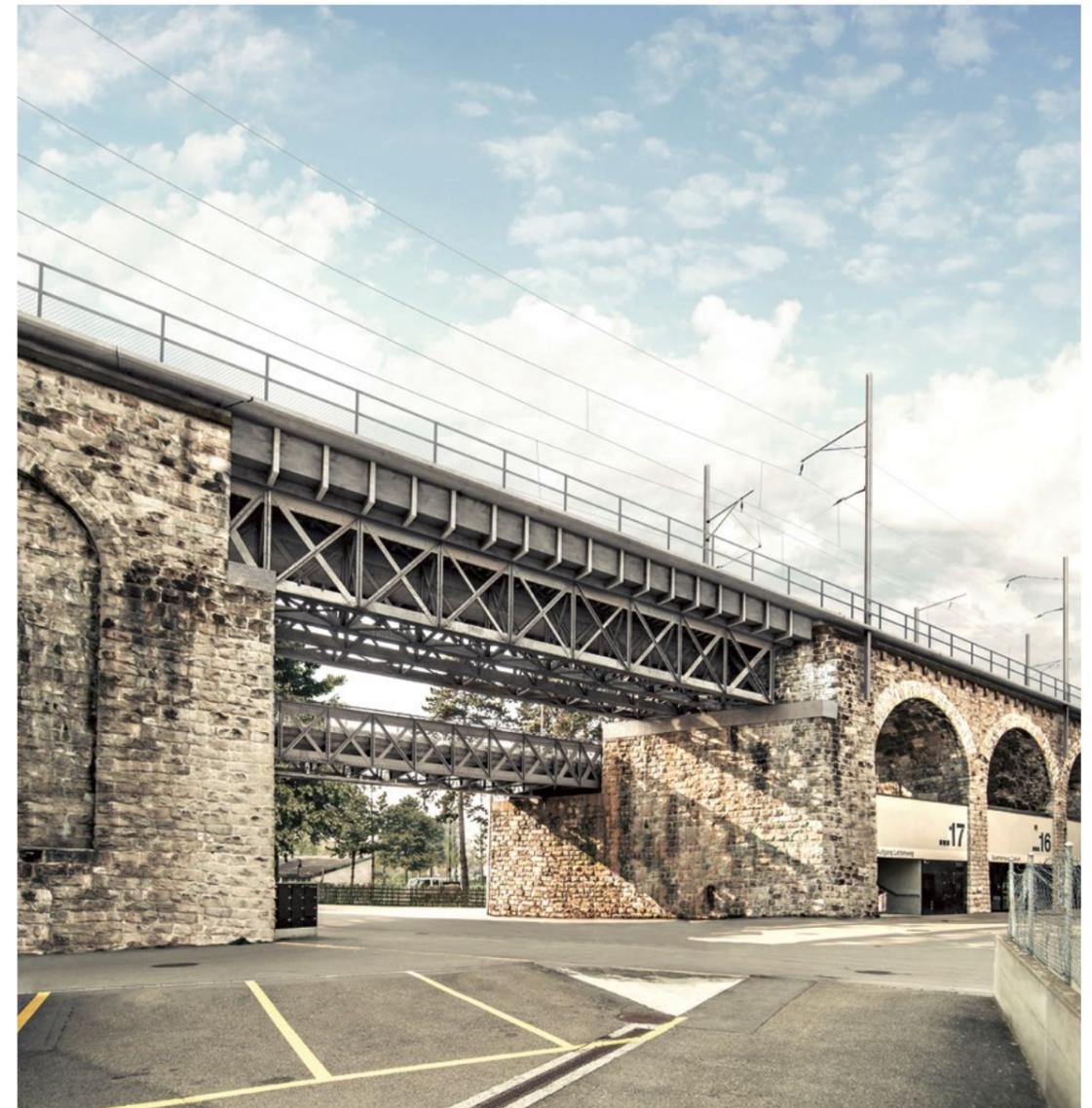
Le béton fibré ultra-performant Ductal permet de rénover des ouvrages en utilisant un minimum de matériaux, comme ici sur le viaduc de Wipkingen à Zurich.
