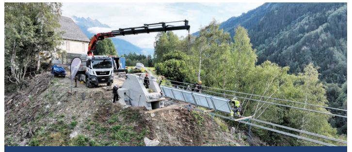
Bauarbeiten an «la pendenta» (Bild: Verein la pendenta, Christian Loretz)
