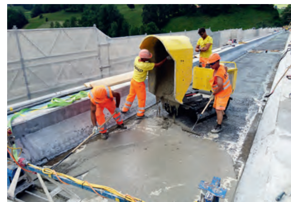
Aufbringen der Ductal®-Schicht auf dem Boden des Trogs.
