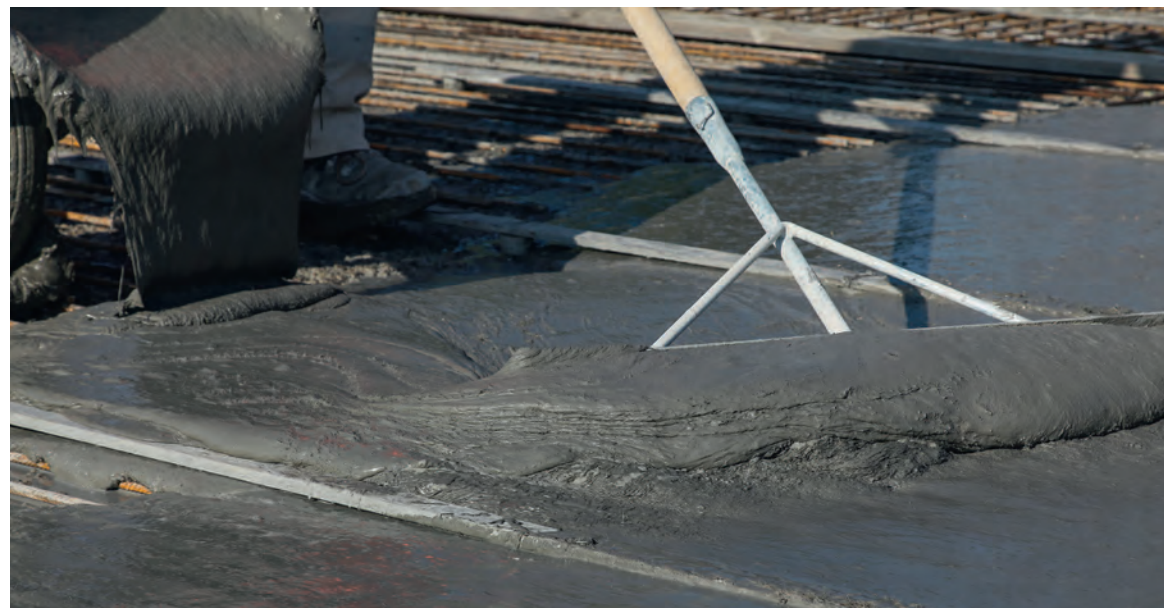
Die Konsistenz von Ductal® ist honigartig und hoch viskos.
