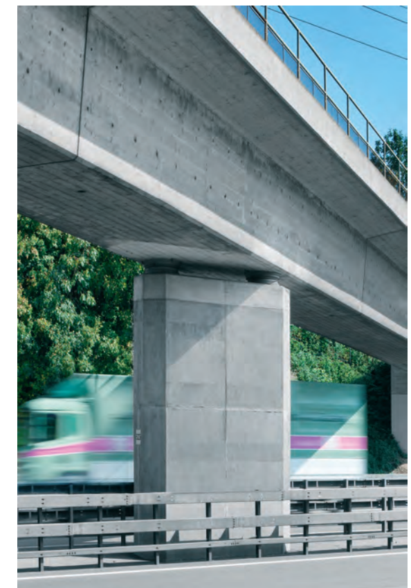
Ummantelung eines Brückenpfeilers mit 40 mm starken Elementen aus UHFB zum Schutz gegen Chloridangriffe (Ausführung: 2010).
