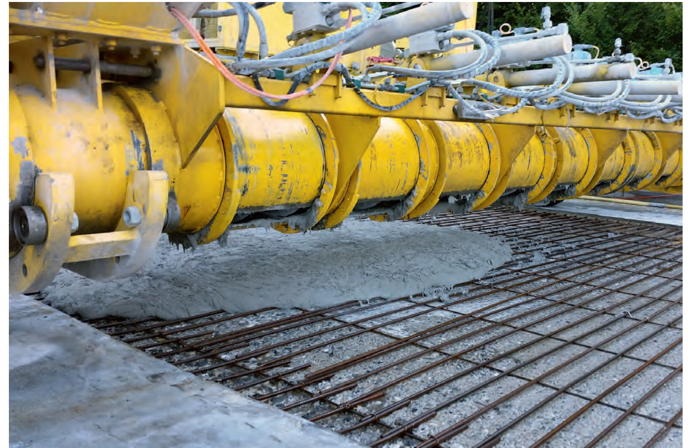
Maschinelles Einbau einer Verstärkungsschicht aus Ductal® mit einem Deckenfertiger (Viaducs de Chillon).
