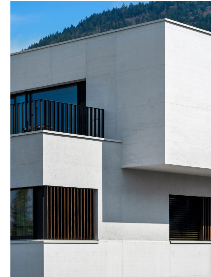
gestockt, schalungsglatt und geschliffen
