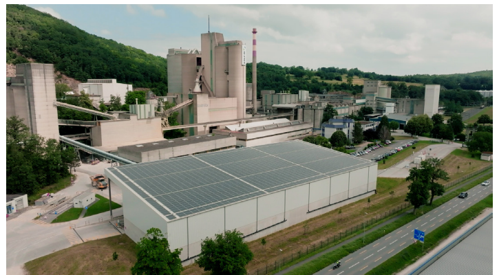
Photo : Installation photovoltaïque de la cimenterie d'Eclépens
