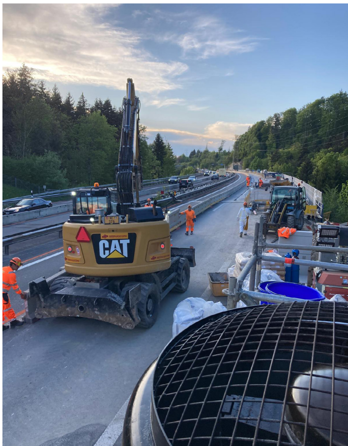
Photo : Assainissement d'un viaduc sur l'autoroute A9 avec Ductal
