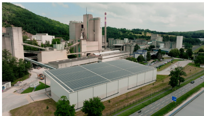
Photo : Installation photovoltaïque de la cimenterie d'Eclépens
