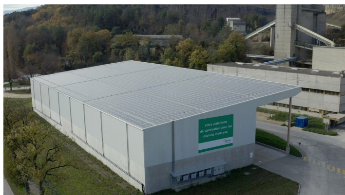
Photo : Halle de recyclage de la cimenterie d'Eclépens
