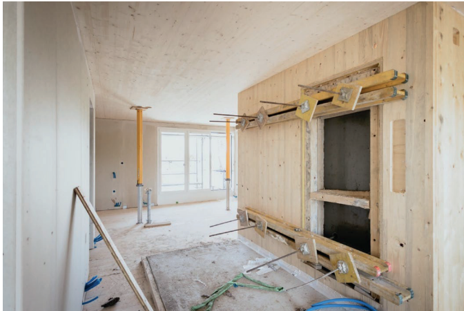
Variante 0: zweischalig Brettschichtholz (CLT) z.B. TS3
