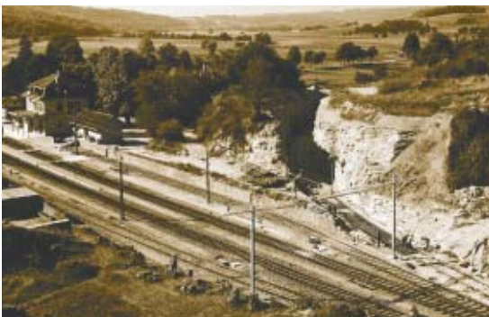
Percement de la tranchée vers la voie CFF
