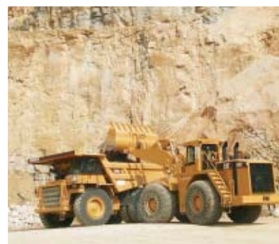
L'abaissement de la hauteur des étages d'exploitation devrait permettre de diminuer les charges d'explosifs et par là-même les vibrations
