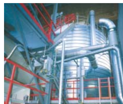
Le nouveau silo de confinement des composés organiques volatils (COV)
