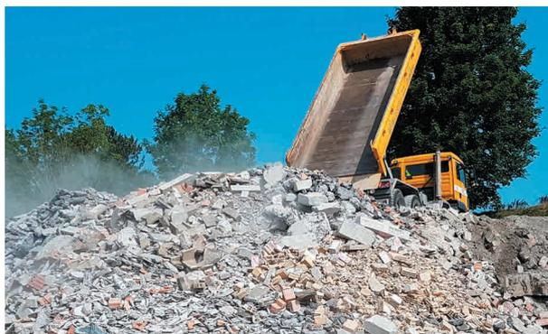
Holcim verwertet in der Zementherstellung hochwertig aufbereitetes Mischgranulat aus rückgebauten Gebäuden.
