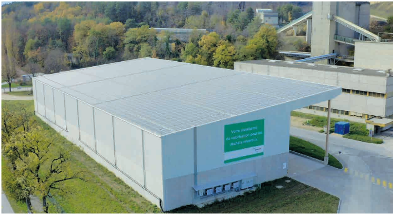
Nouvelle plateforme de valorisation de déchets minéraux
