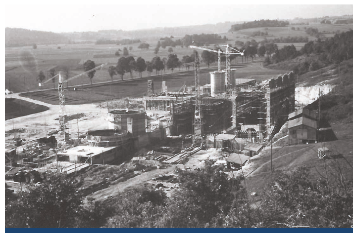
Chantier de la cimenterie (1952)
